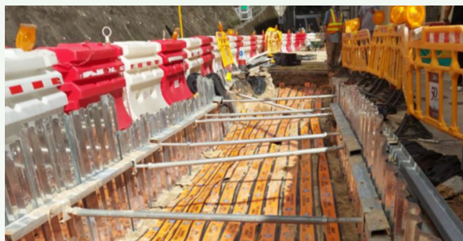
荃灣區分區電纜鋪設工程現場
