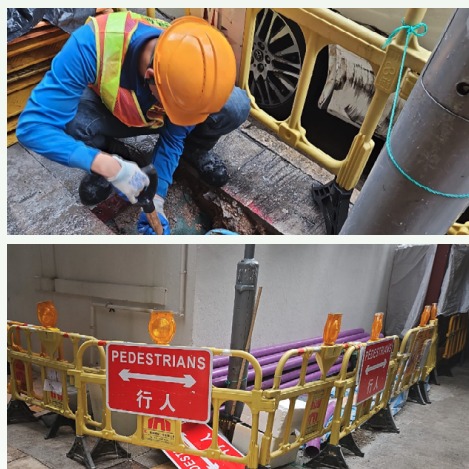
九龍城區路燈電路改善工程
